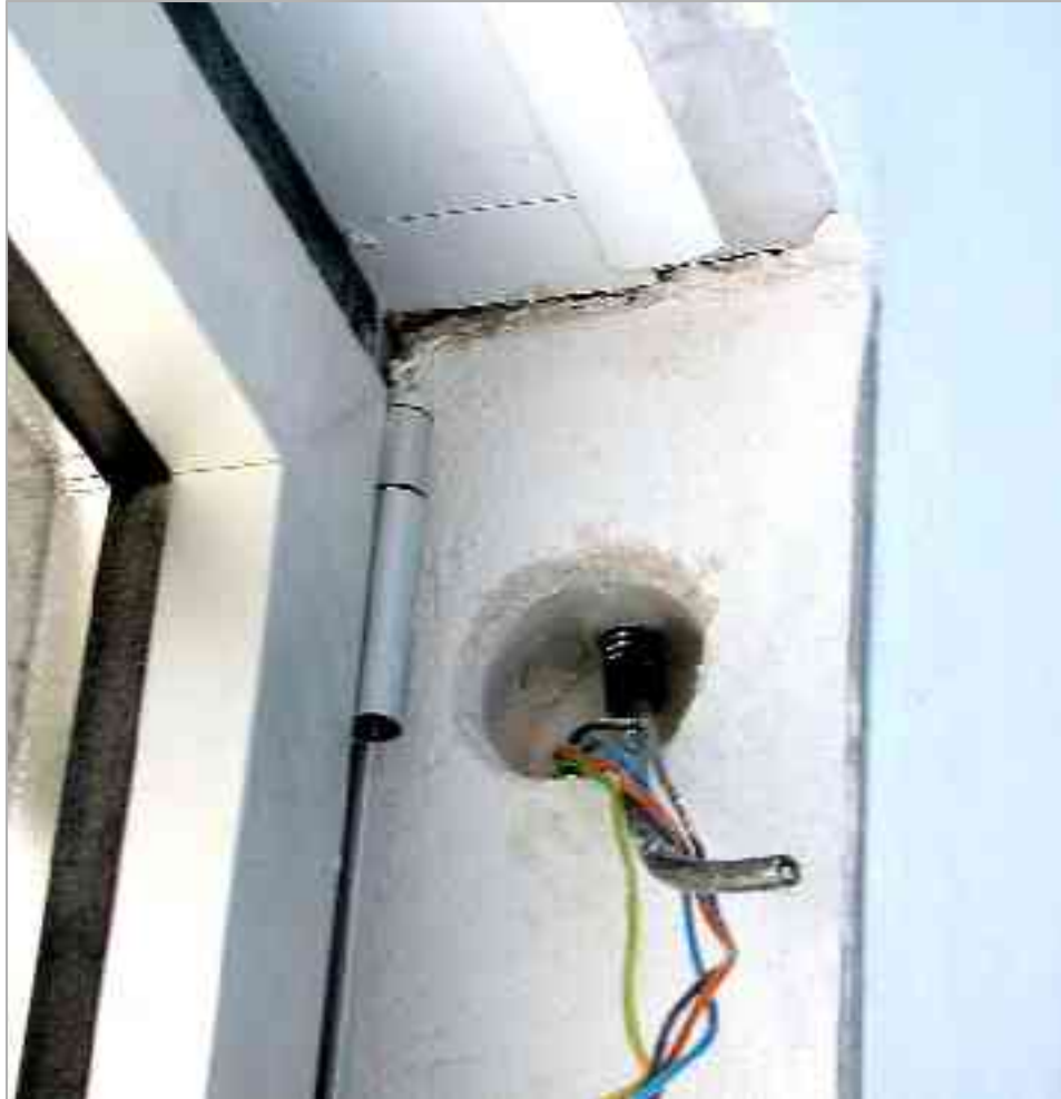
Leerrohr ersetzt Rollladengurt
